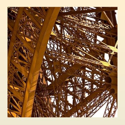
Gustave Eiffel va utiliser des charpentes métalliques, plus légères et plus rapides à installer que les structures en pierre ou en béton. Ainsi, la Tour Eiffel est conçue comme un mécano géant où chaque pièce est dessinée par des ingénieurs. Les morceaux sont usinés en atelier puis assemblés sur place.
