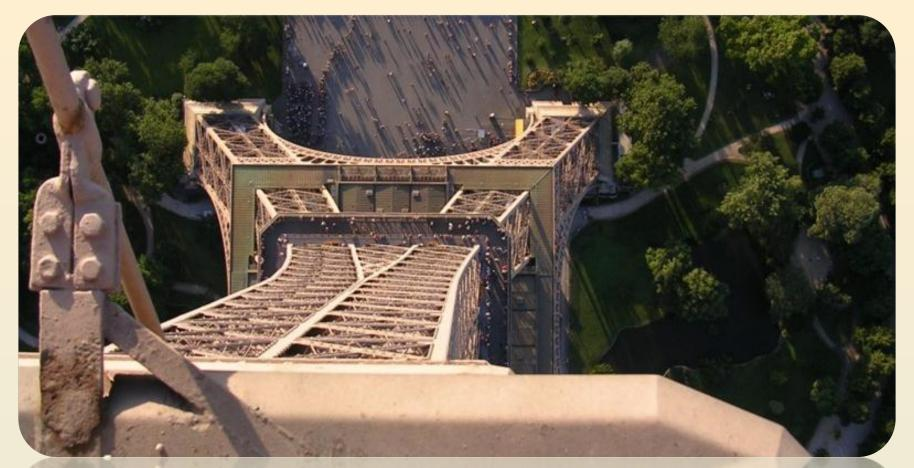
Un observatoire des mouvements du sommet permet de retracer les oscillations de la tour sous l'effet du vent et de la dilatation thermique. Gustave Eiffel a exigé qu'elle puisse supporter une amplitude de 70 centimètres, ce qui n'a jamais été le cas: lors de la canicule de 1976, l'amplitude de l'oscillation a été de 18 cm et de 13 cm lors de la tempête de décembre 1999 (vent de 240 km/h).
